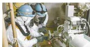
放射線物質を建屋内に閉じ込めるため、廃ガス処理設備の弁を閉止操作する訓練
